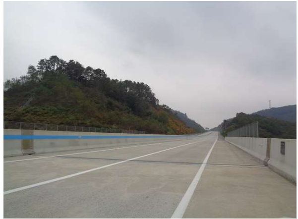
교량 상부 전경
