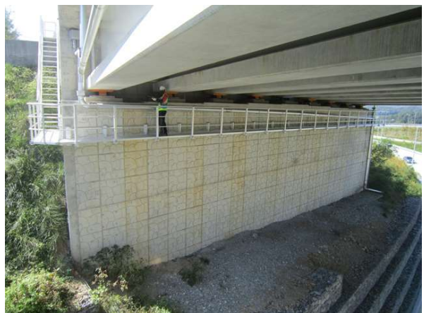
교량 하부 전경
