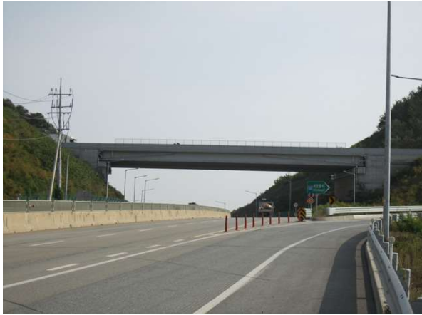
교량 측면 전경
