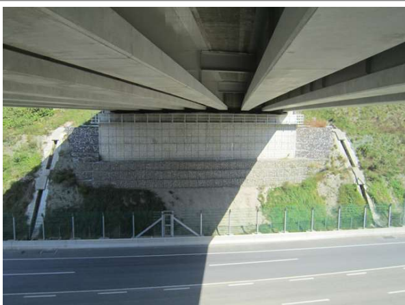
교량 하부 전경
