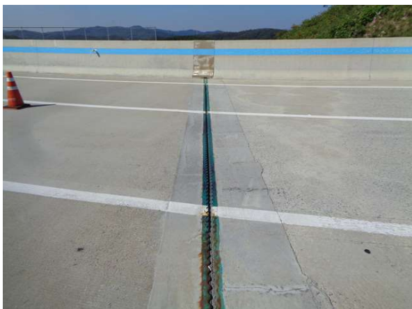
교량 상부 전경
