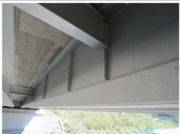
교량 거더 전경
